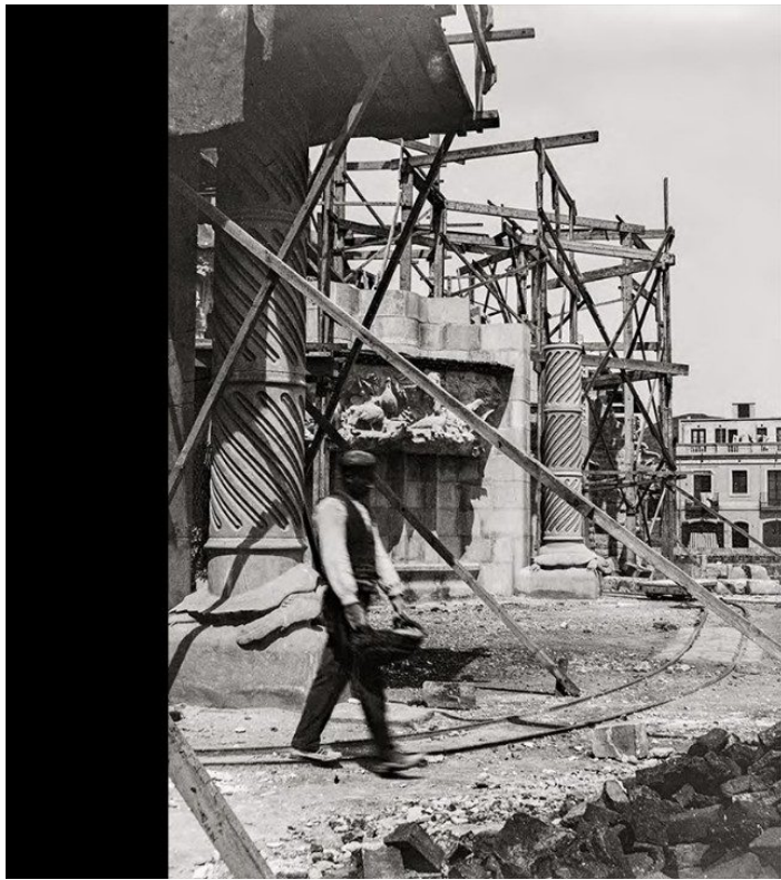
Cantiere della Sagrada Família, 1895.
